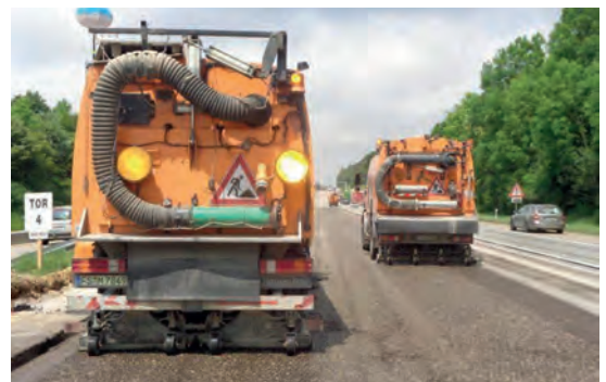
Abb.1: Wasserhochdrucktechnologie zur optimalen Reinigung der Asphaltoberfläche
