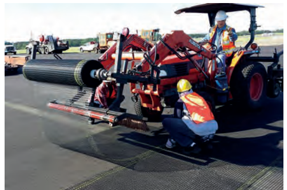
Abb. 3: Maschinelle Installation von GlasGrid GG
