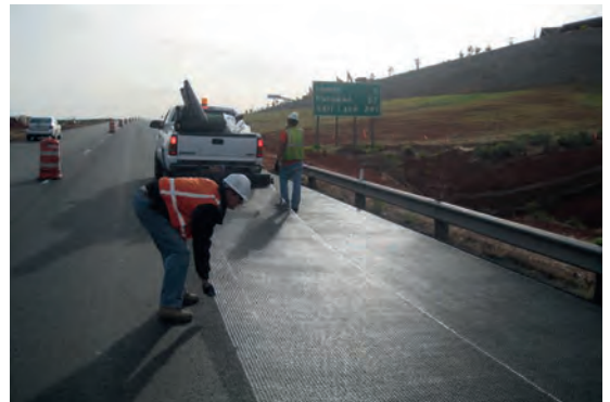
Abb. 4: Manueller Handeinbau von GlasGrid GG
