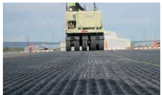
Abb. 2: GlasGrid GG – Installation, Aktivierung des selbstklebenden Effektes durch gummibereifte Walze.
