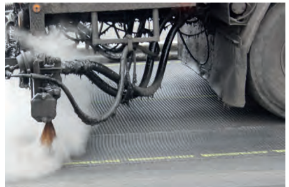
Abb. 8: Ansprühen GlasGrid GG mit Haftmittel
