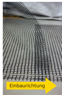
Abb.5: Überlappung von Gitterenden
