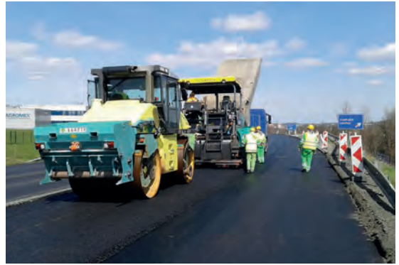
Abb. 9: Deckschichteinbau
