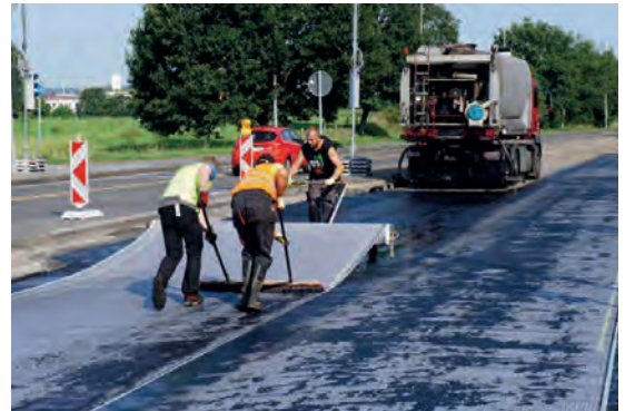
Abb. 5: Manuelle Verlegung GlasGrid CGL
