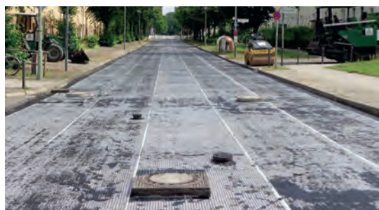
Abb. 2: Typische GlasGrid CGL/ CG Verlegung auf gefräster Oberfläche (optimal durchtränktes Gitter)
