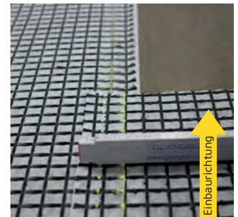
Abb. 7: Längsüberlappung von Gitterenden
