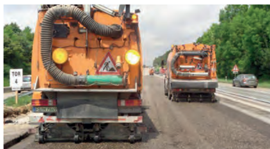
Abb.1: Wasserhochdrucktechnologie zur optimalen Reinigung der Asphaltoberfläche
