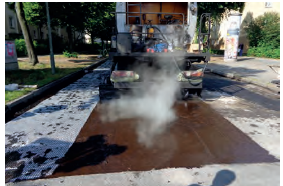
Abb. 3: Haftschieftauftrag vor GlasGrid CGL Verlegung
