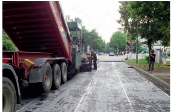
Abb. 9: Deckschichteinbau
