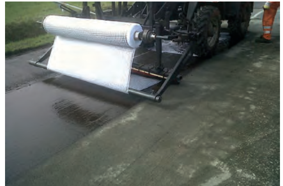
Abb. 4: Maschinelle Verlegung GlasGrid CGL
