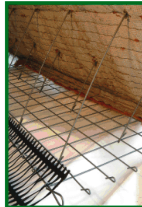
Bild 2: Verbindung des Bodenelementes mit dem Bewehrungsgitter mittels Steckstab
