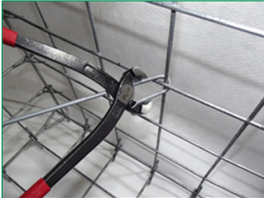
Distanzhalter diagonal eingehangen
