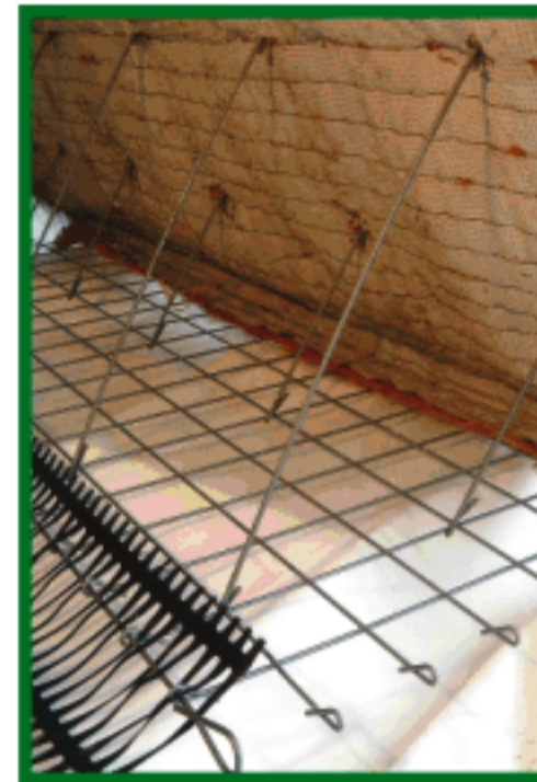
Bild 2: Verbindung des Bodenelementes mit dem Bewehrungsgitter mittels Steckstab
